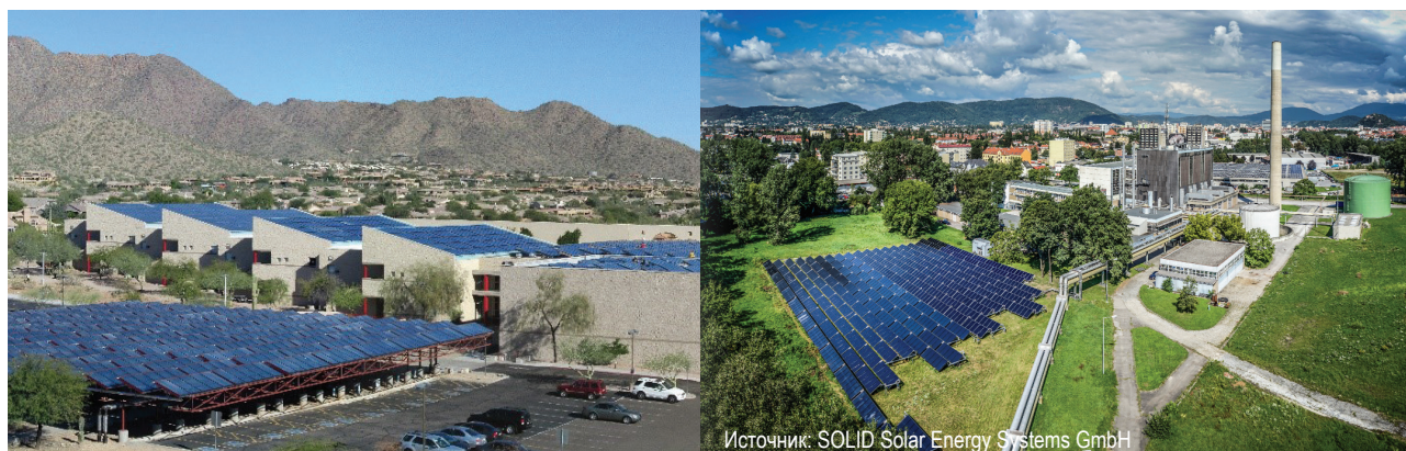
Фотография 7. Установка солнечного районного холодоснабжения, г. Скотсдейл, Аризона (США) (слева) и часть парка коллекторов районной теплоцентрали в г. Граце (Австрия) (справа)
