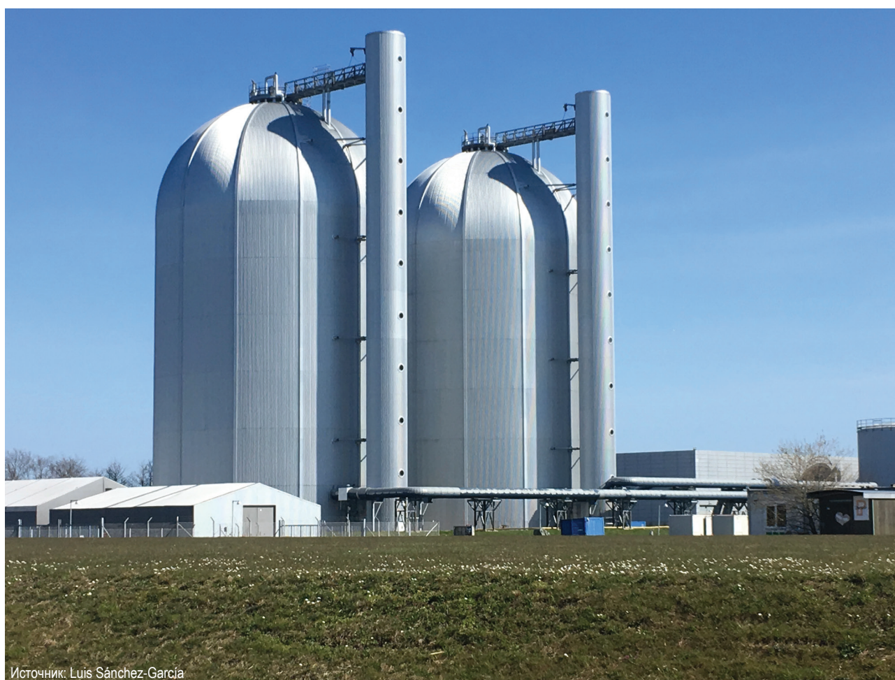
Фотография 4. Аккумулирование тепловой энергии (44 000 м 3 ) в Avedøre Kraftværket в Копенгагене (Дания)
